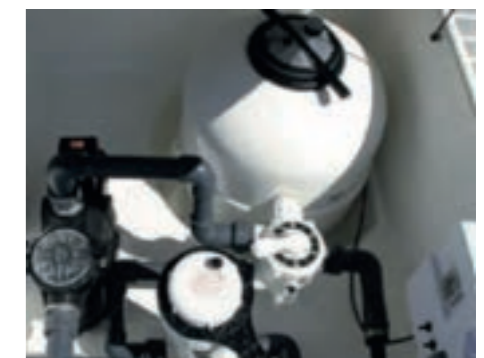
9. Pose du groupe de filtration
