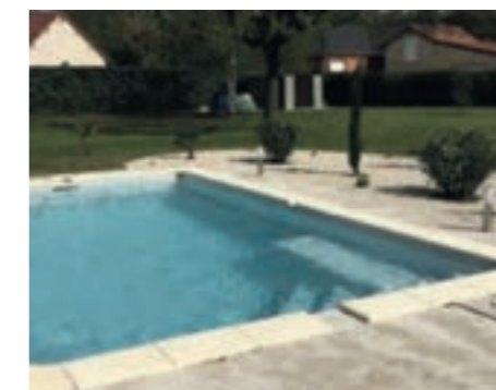
8. Pose des margelles
