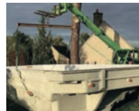
4. Pose en fond de fouille
